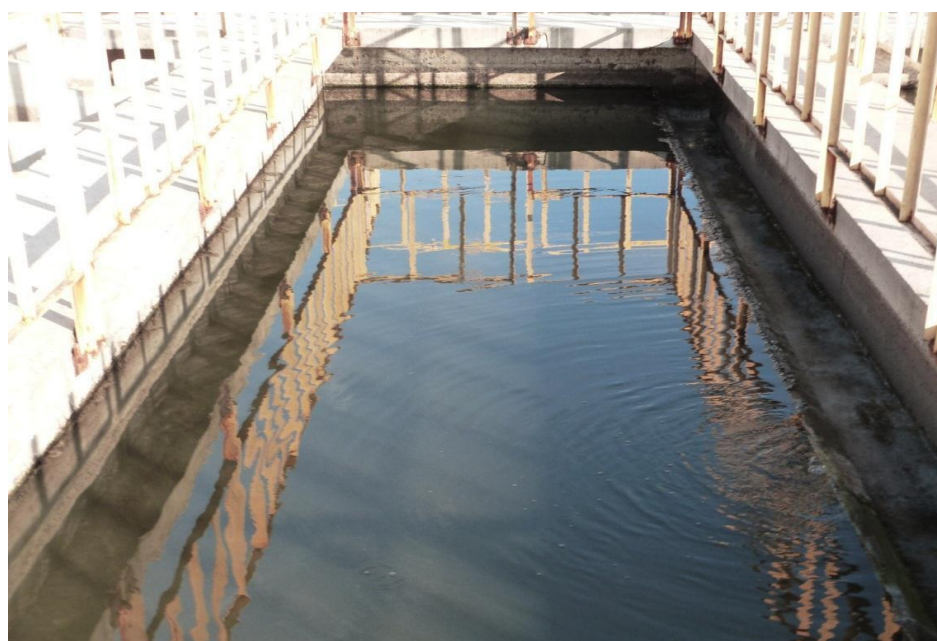
Figura 106: Estação de Tratamento de Esgoto – Reator UASB.
