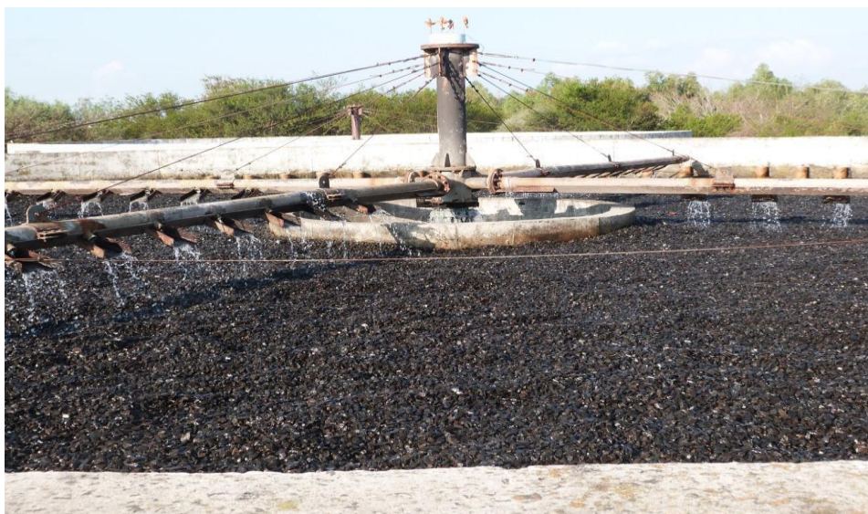
Figura 105: Estação de Tratamento de Esgoto – Filtro Biológico Percolador.
