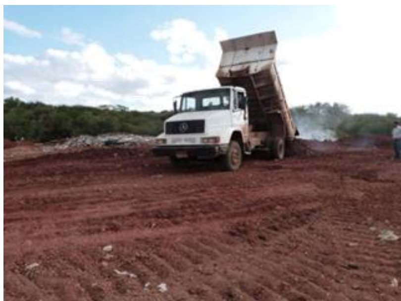
Figura 176: Recebimento dos resíduos nas células do aterro.
