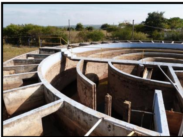
Figura 61: Estação de Tratamento de Água.
